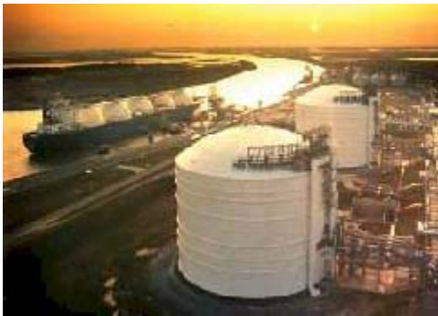
LNG IMPORT TERMINAL AT LAKE CHARLES
