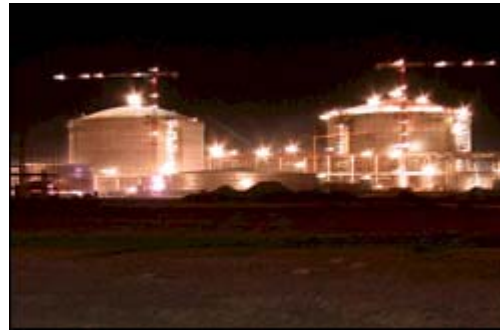
LNG TANKS AT PLL SITE AT DAHEJ, INDIA
