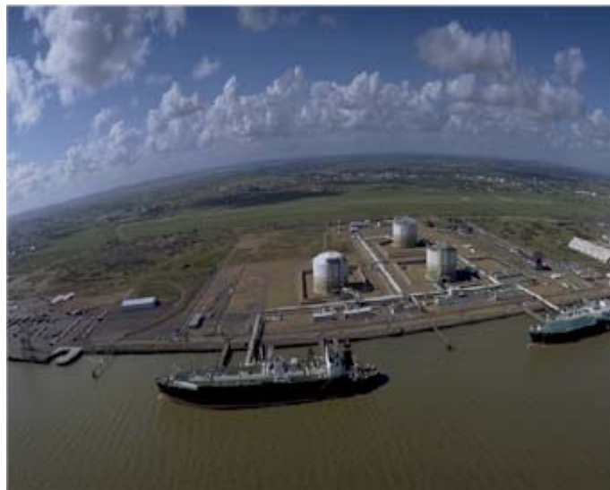
General view LNG Terminal
